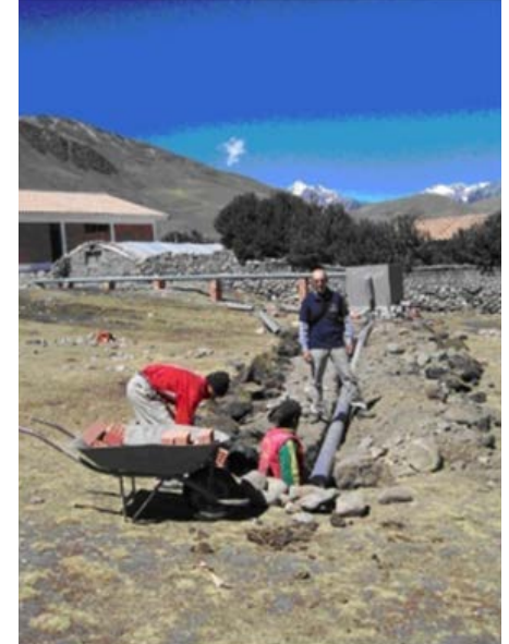
José Antonio Mancebo trabajando en la instalación de depuración de aguas negras de los servicios higiénicos de la escuela de la comunidad Mallma
